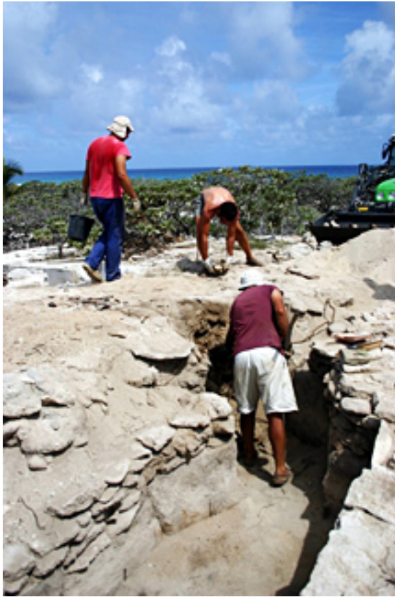
Etude des fondations du bâtiment météo détruit. Crédit photo : Laurent HOARAU
